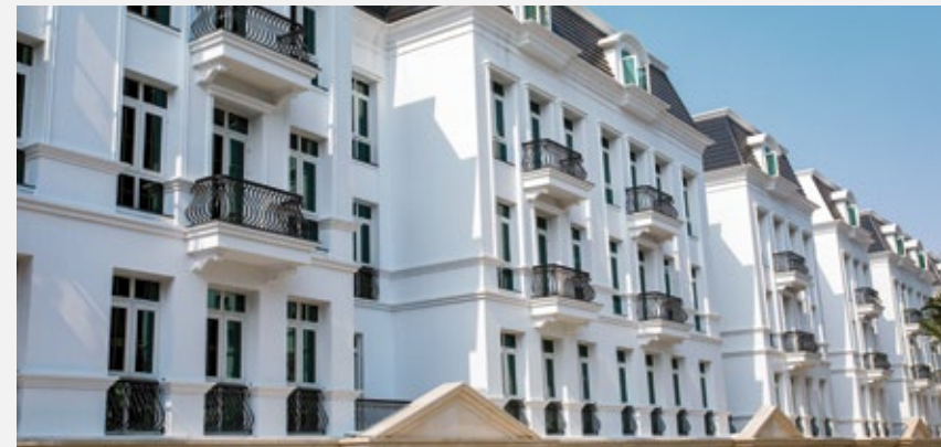
Khối thấp tầng dự án Grandeur Palace - Giảng Võ
