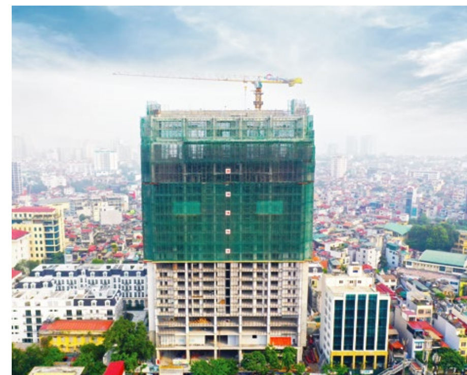
Dự án Grandeur Palace - Giảng Võ
